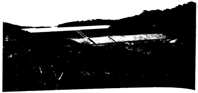
Hình 1. Đập tràn sự cố hồ Yên Lập
